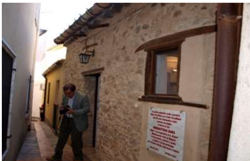
2. L'esterno della casetta-tugurio restaurata.
